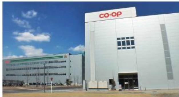
日本生協連 冷凍食品の取扱品目拡充にあたり 中国・四国エリアの拠点として稼働している尾道冷凍流通センター
